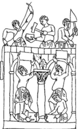
Будаўніцтва дома. З мініяцюры XII ст.).
