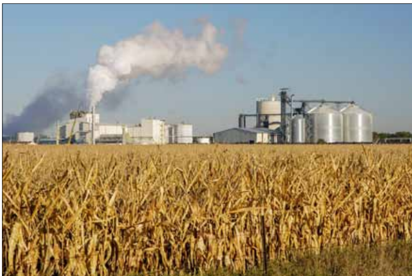
Іл. 2.10. Біягазавая станцыя ў ЗША.
