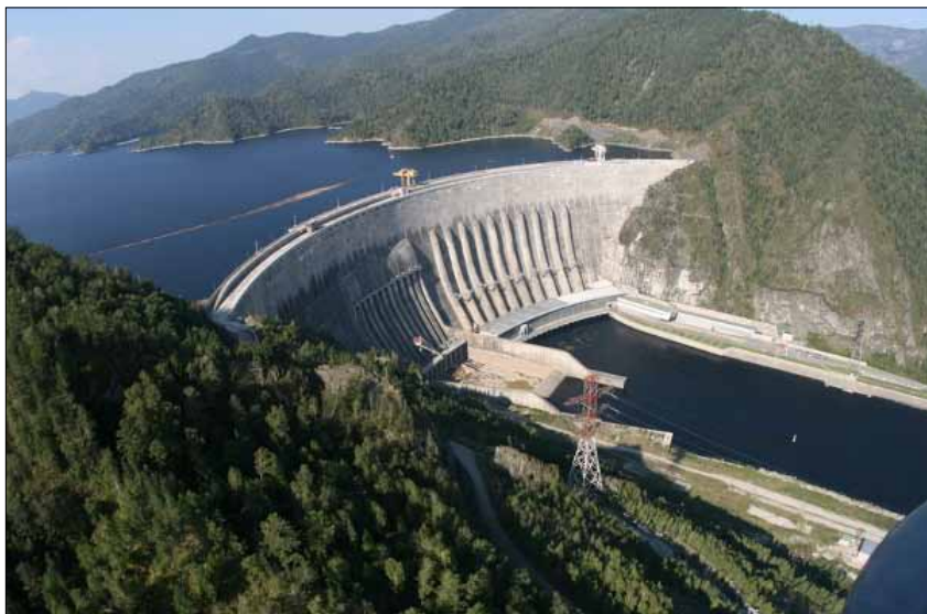
Іл. 2.11. Саяна-Шушанская гідраэлектрастанцыя, Расія.
