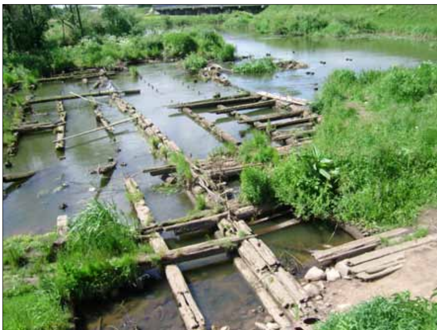
Рэшткі былога драўлянага моста цераз Друць у Бялынічах (з дадатковых канструкцый калісьці быў млын і «ледарэзы» – палі для драблення лёдавай масы пры вясновым крыгаходзе).
